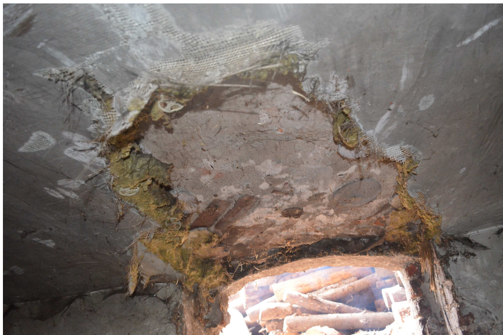
Strop odcinkowy pomiędzy piwnicą a parterem w części północnej budynku
